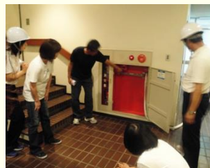
消火栓の使用方法的確認
